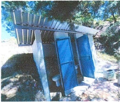
Foto 3: sustitucion de techa a baños
