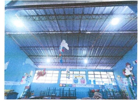
Foto 8: flaponeras y cambio de focos grandes ahorradores para 3 aulas y corredor
